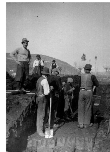
Figura 1: Operai in una trincea di scavo
